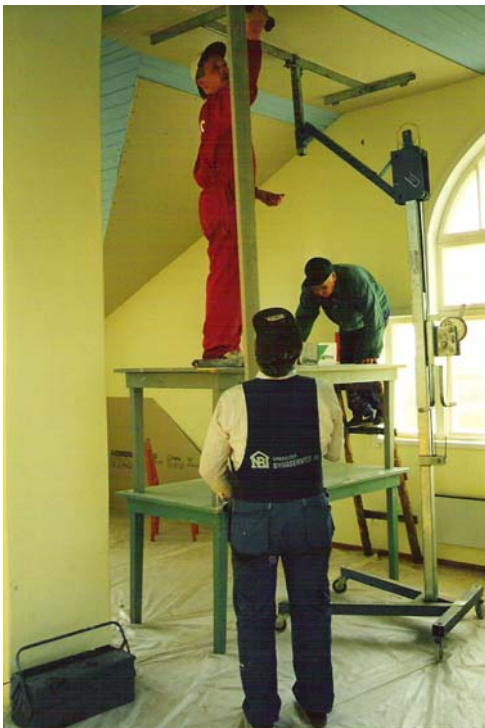
1998 renoverades vindsvåningen. Väggarna målades och innertaket bekläddes med gipsskivor. Här talkojobbar Kent Nygård, Sven Åhman och Lars Eriksson.
